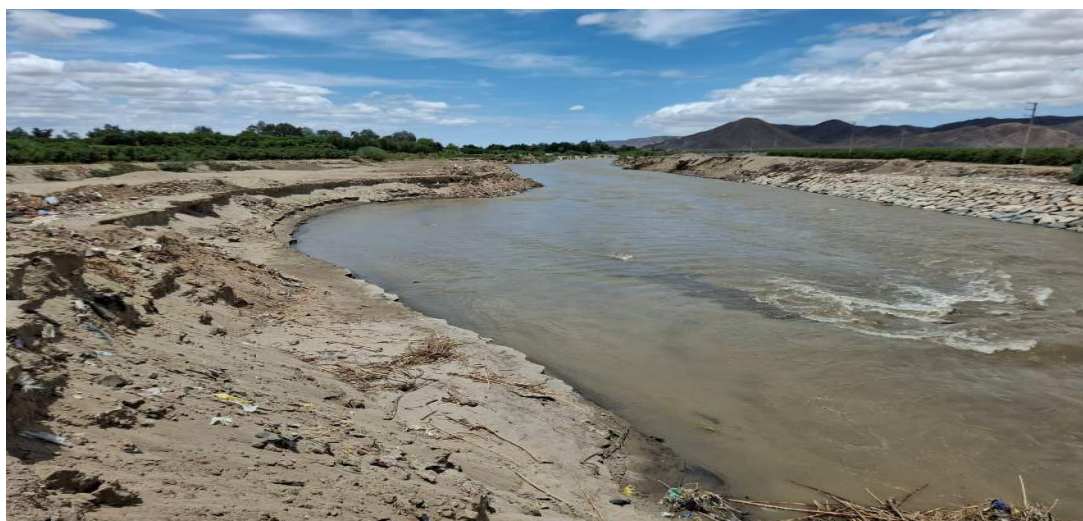
FOTOGRAFIA 04: Tramo crítico en la Margen Derecha del rio Ica se observa la erosión que requiere de protección mediante estructura de dique enrocado
