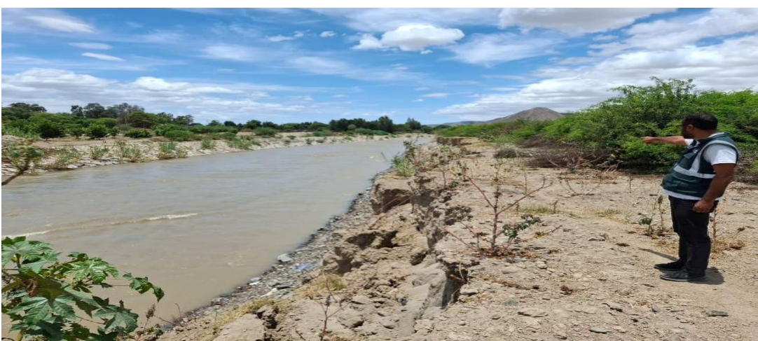
FOTOGRAFIA 04: Tramo crítico en la Margen Derecha del rio Ica se observa la erosión producto de la maxima avenida en el mes de febrero del 2026
