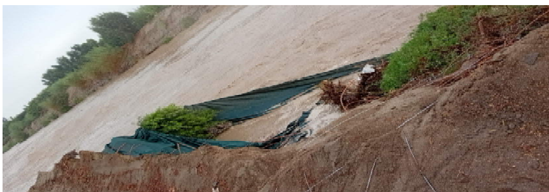
FOTOGRAFIA 02: Tramo crítico en la Margen Izquierda del río Ica donde se requiere de proteccion con estructura permanente
