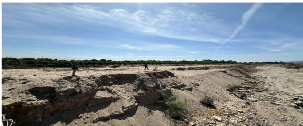
FOTOGRAFIA 01: Tramo crítico en el río Ica Para Limpieza Y descolmatacion en una longitud de 2,760.00 ml
